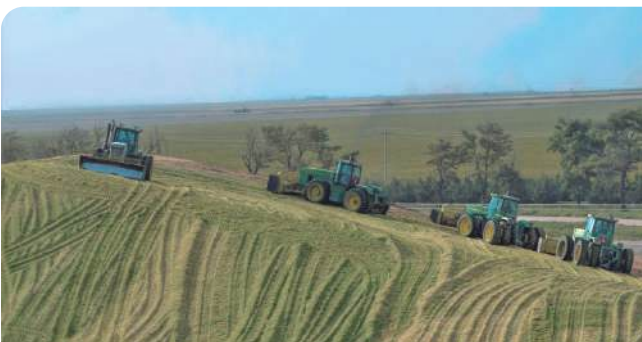
Una densidad de compactación uniforme es fundamental para un almacenamiento estable.
